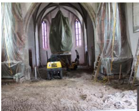
Der Fußboden wurde komplett entfernt. Rammerstorfer
